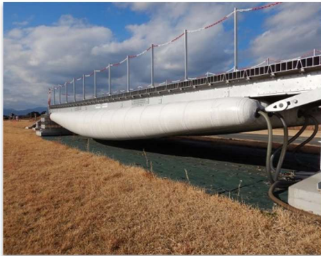
PS-Bridge® (ヒロセホールディングス) 空気膜式緊急復旧橋
